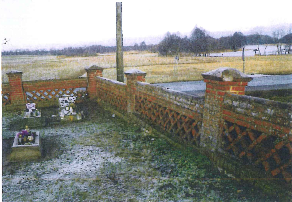
Fot.12. Ogrodzenie cmentarza w narożniku północnym. Widoczny stan zachowania i znaczne odchylenie przęseł ogrodzenia.
