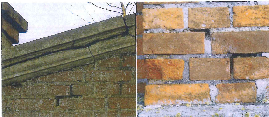
Fot.10. Fragment lica ceglanego na elewacji kaplicy po stronie południowo-wschodniej. Widoczny stan zachowania: ubytki oryginalnych spoin, wykruszenia cegieł i wtórne uzupełnienia spoin.
